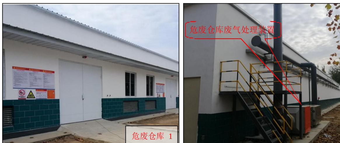
图2.2-7 危废仓库1现场情况
